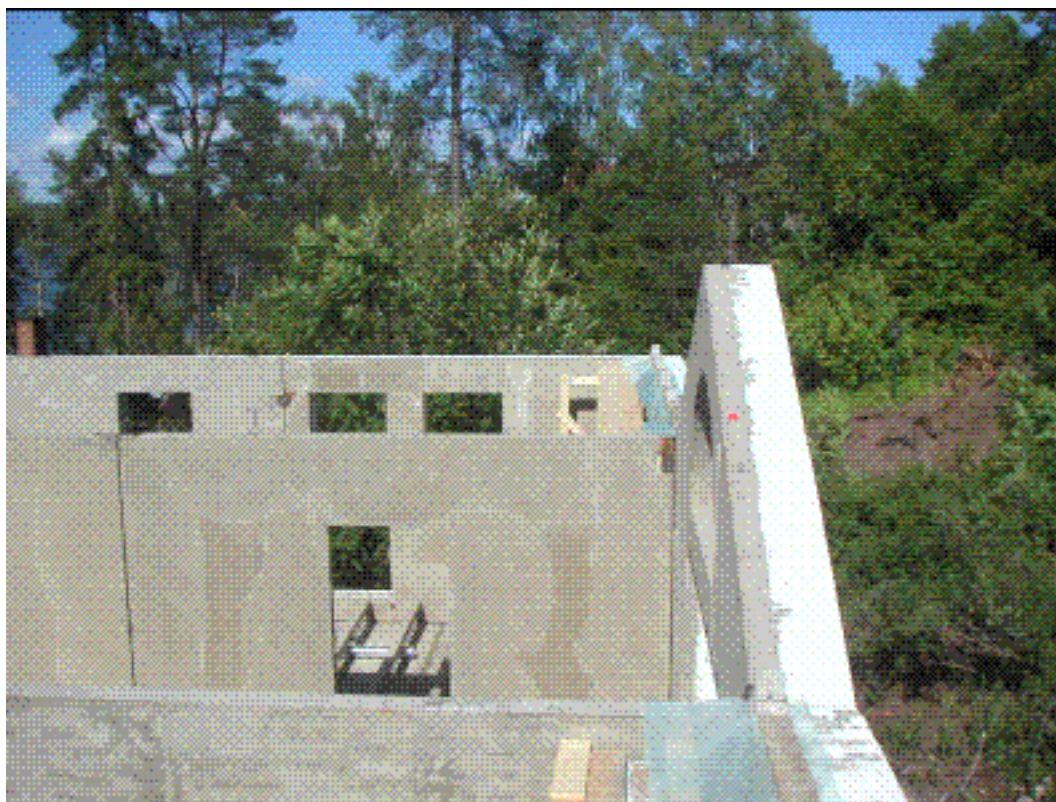
Panorama del 5 Här syns hur välisolerat huset är.
