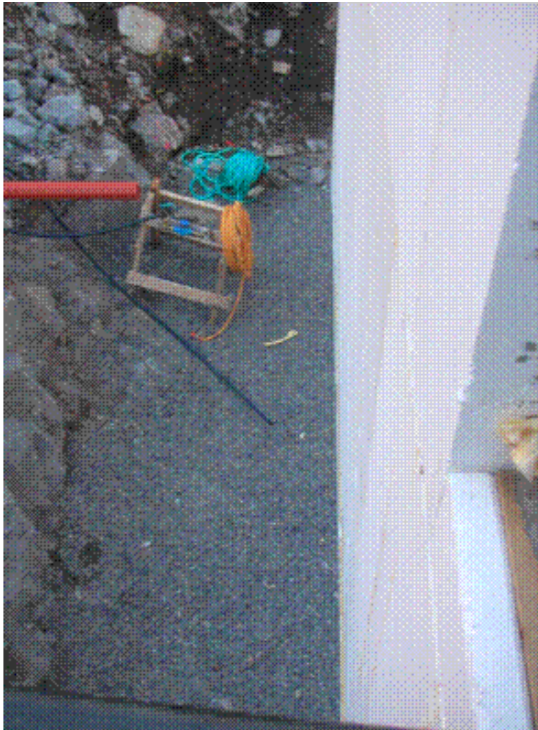
Ytternväggen redan färdig för puts
