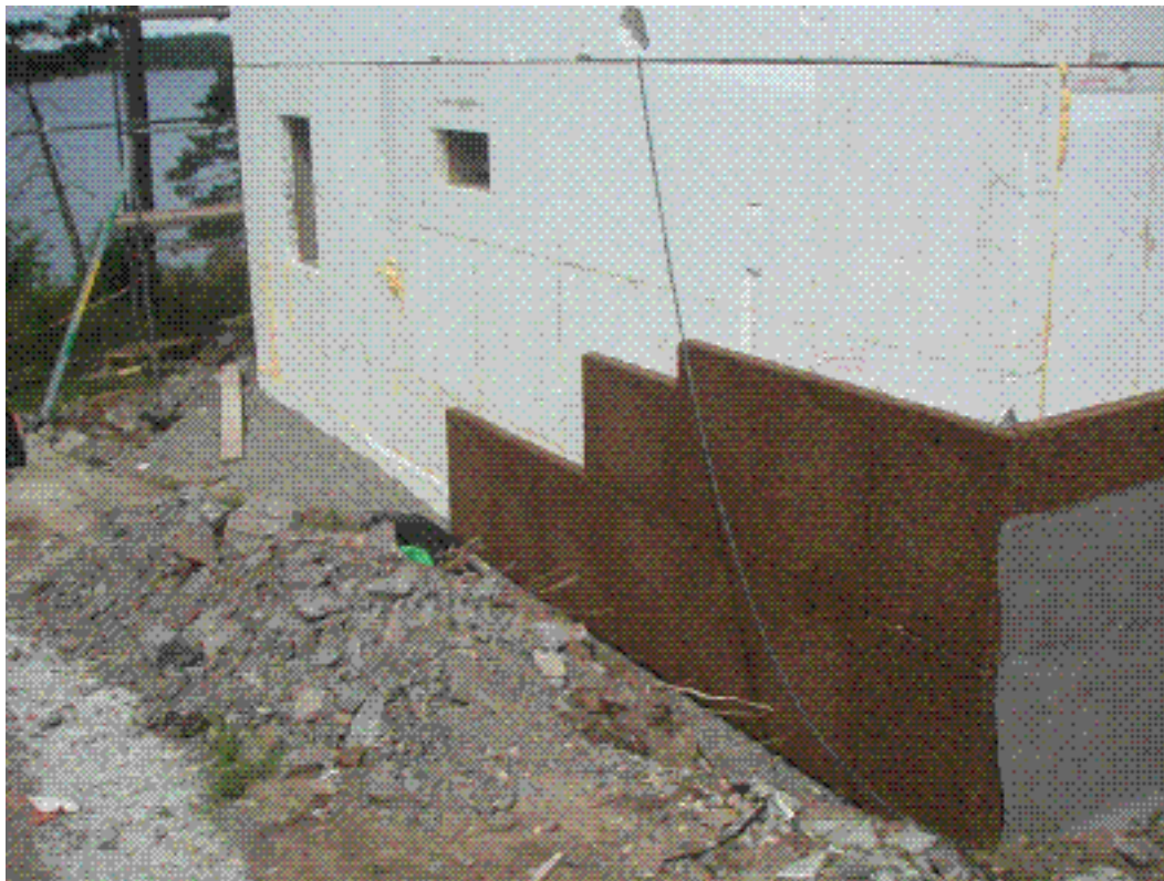
Dränerande skivor och s.k. geoduk av glasfiber. Dags att motfylla.
